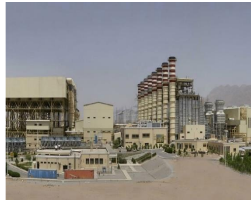
شکل ۱- الف: واحد گازی، بویلر و خنک کننده
